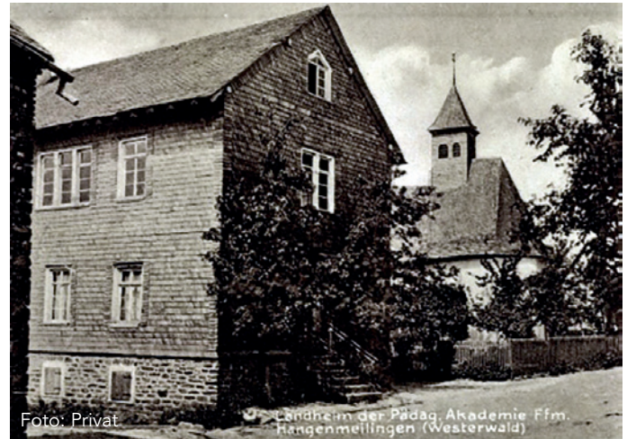
Schulgebäude Hangenmeilingen (Rückansicht)
