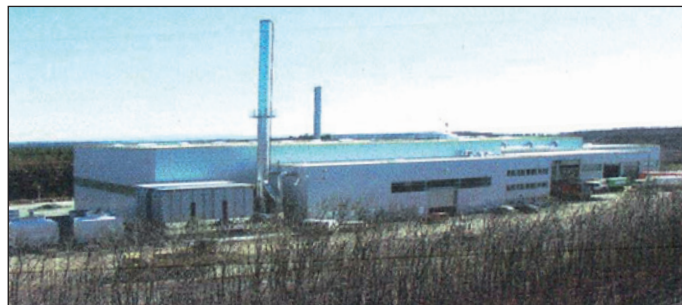
In der MBS-Anlage Westerwald in Rennerod wird heute aus Abfall Brennstoff gewonnen
